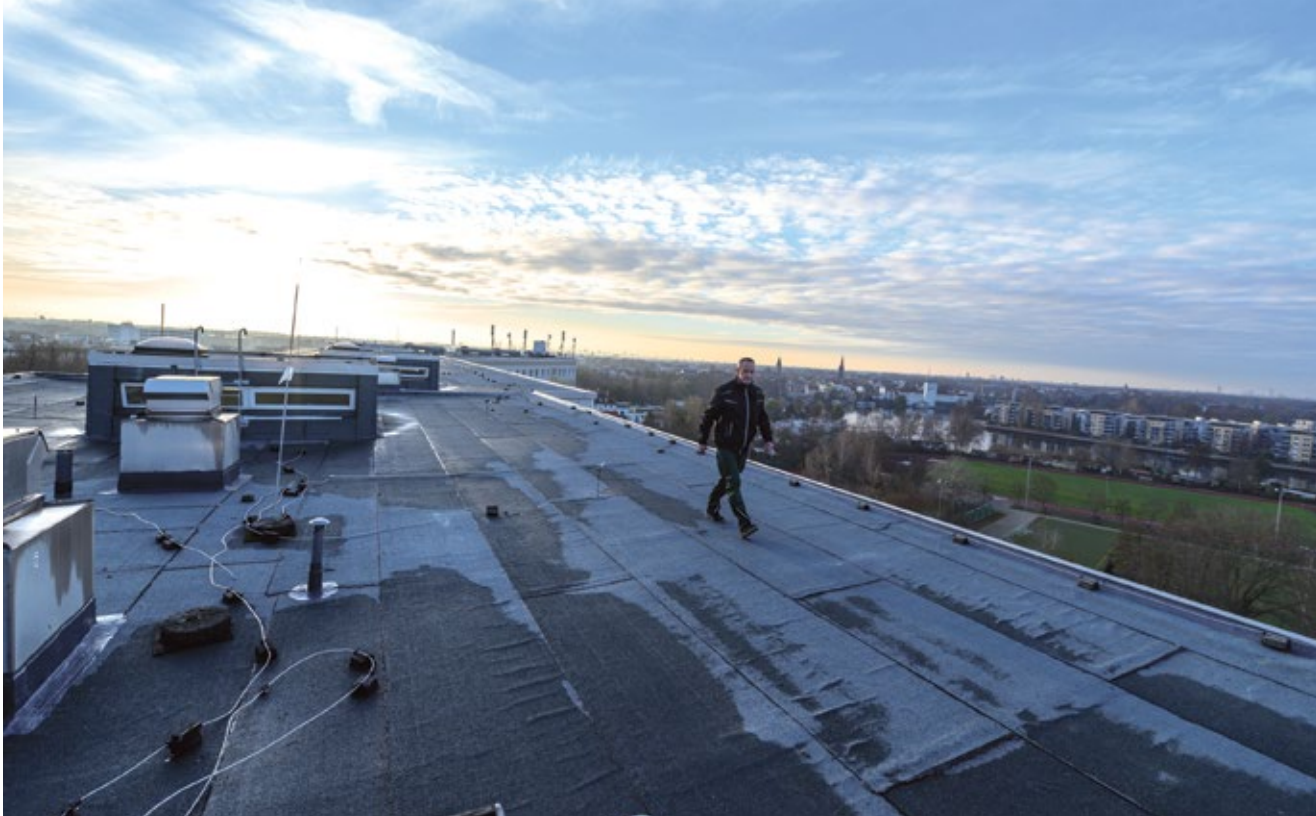
Hausmeister Olaf Emmrich bei der Dachbegehung auf dem S-Block. – Bild: Cathrin Bach
