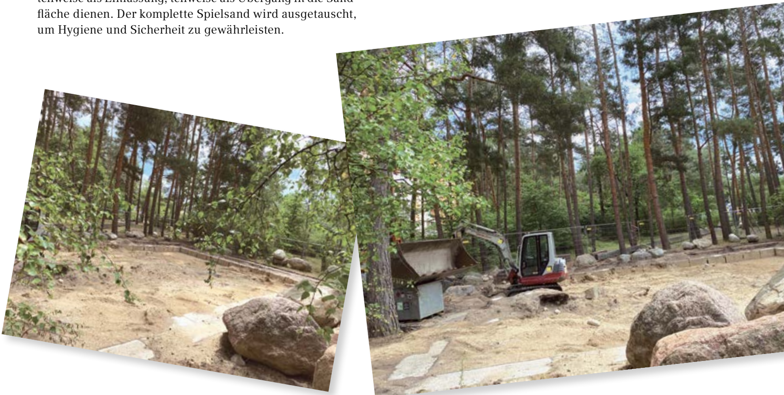
Baustelle auf dem ehemaligen Wasserspielplatz (links), Vorbereitung der Sandfläche für das neue Wasserspielelement (rechts)
