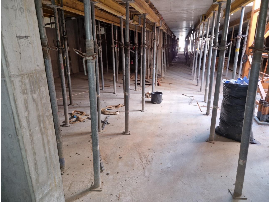
Abbildung 1: Foto Tiefgarage Haus Süd (Aufgenommen am 15.06.2023)
