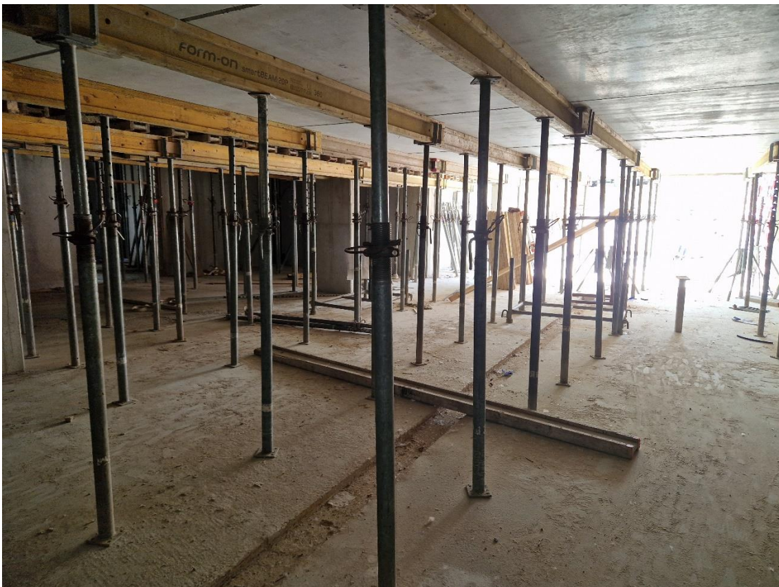
Abbildung 2: Foto Tiefgarage Haus Süd (Aufgenommen am 15.06.2023)
