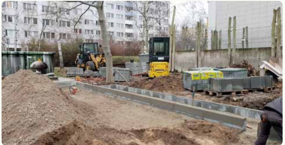
Freifläche am Müllplatz Müggelschloßchenweg 16/18
