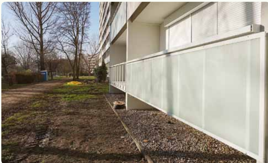
Neue Loggien im Erdgeschoss
