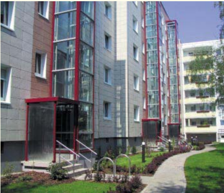
Aufzüge in der Wohnanlage Grüne Trift ...
