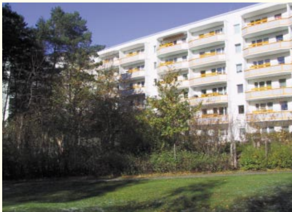
Der Anbau der Loggien ist abgeschlossen.
