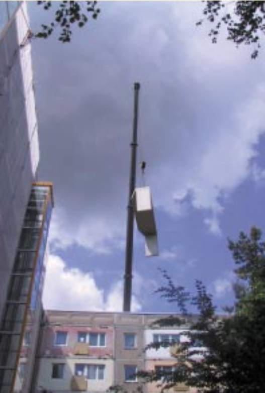
Für die Montage der 8 Tonnen schweren neuen Loggien ist der Einsatz eines 160-Tonnen-Kranes erforderlich
