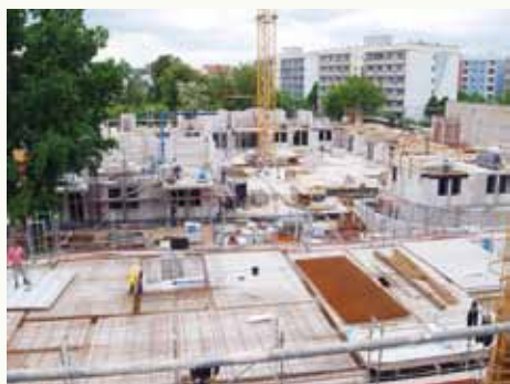
Blick auf die entstehende Wohnanlage
