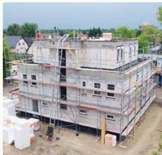
Der Rohbau nimmt zusehends Gestalt an.
