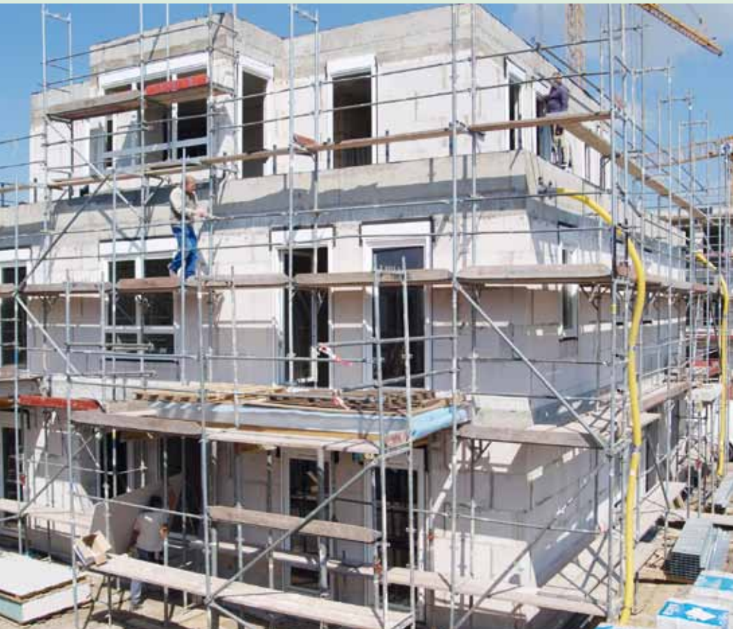
„Quartier Charlotte“ – Der Innenausbau hat begonnen.
