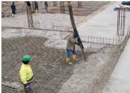
Gießen der Bodenplatte
