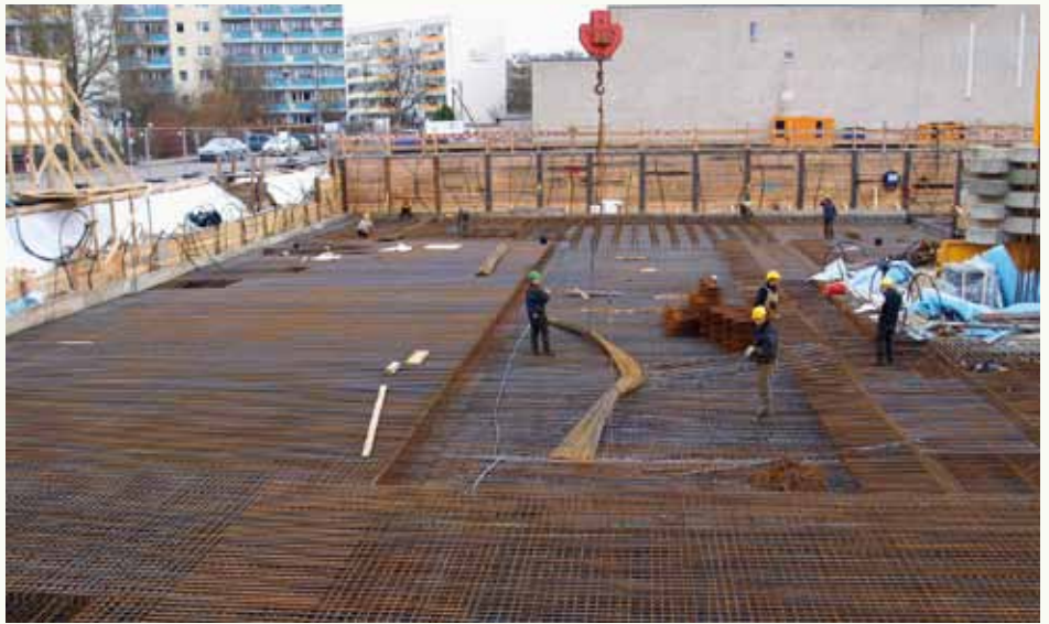
Einbringen des Bewehrungsstahls
